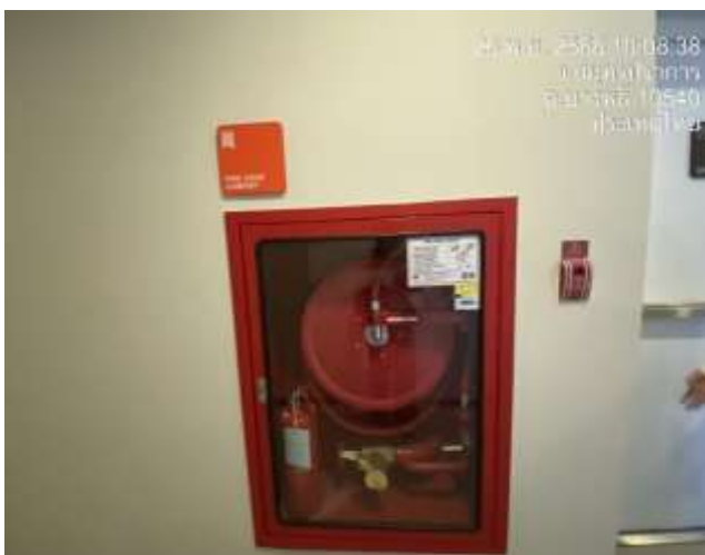
ตู้เก็บสารชนิดน้ำดับเพลิงพร้อมอุปกรณ์
