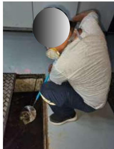
การสูบน้ำออกส่วนเกินจากระบบบำบัดน้ำเสีย
