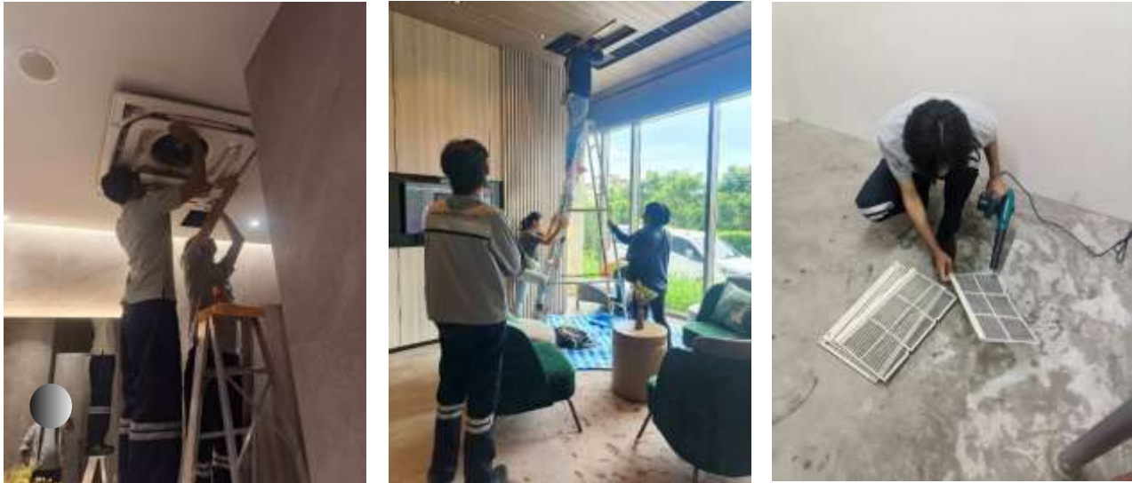
ภาพที่ 2-16 ล้างเครื่องปรับอากาศ
