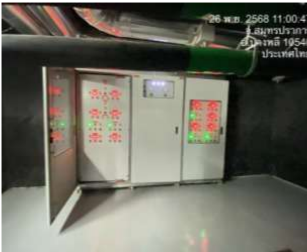
ตู้ควบคุมของระบบบำบัดน้ำเสีย
